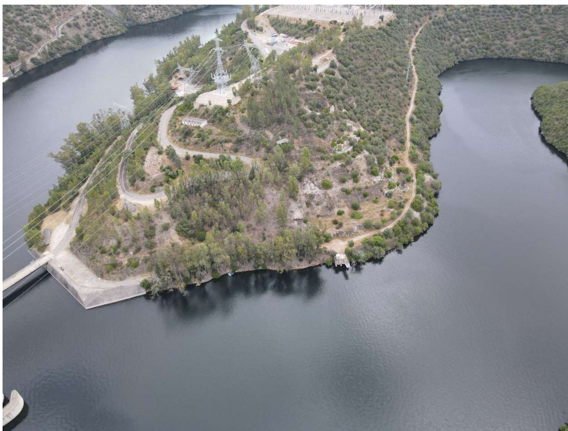
Ilustración 18: Vista panorámica del lado español (subestación de Cedillo y líneas de alta tensión)
